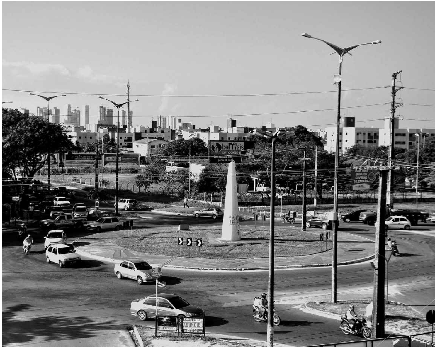
A instalação do trevo de Mangabeira possibilitará o escoamento do tráfego viário na região, possibilitando maior fluidez na área
